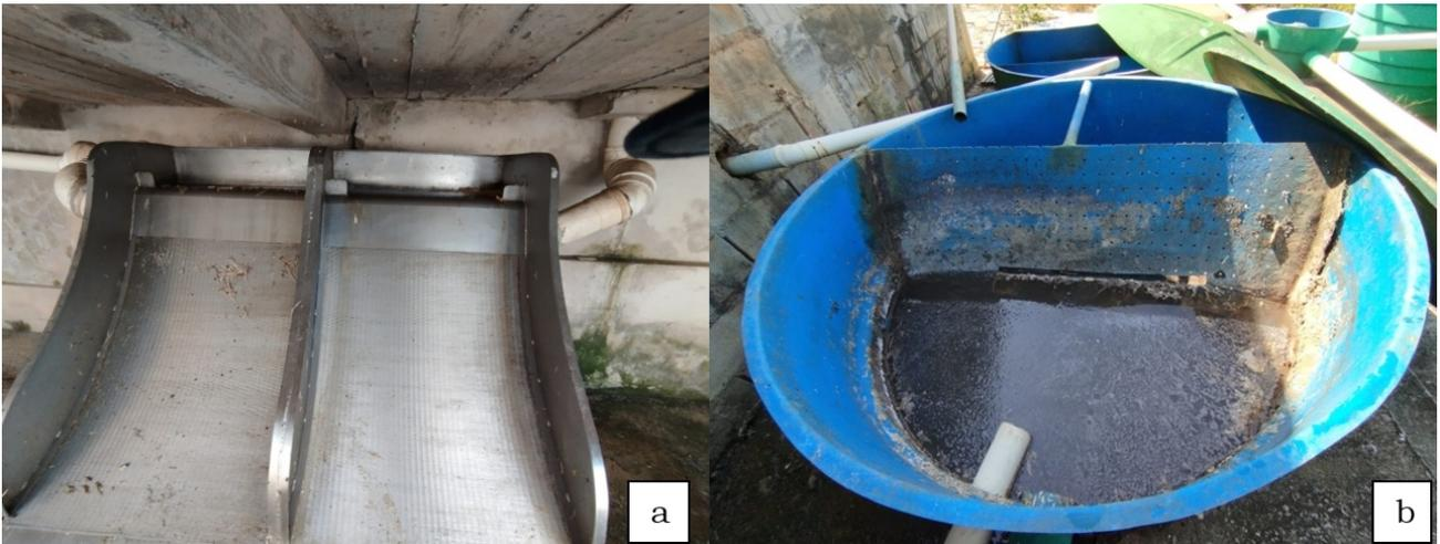
Foto 2 – Tratamento Secundário composto por Reatores UASB seguidos de Filtro Anaeróbio.
