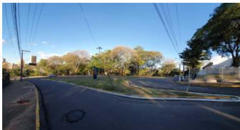
Figura 6 – Vista da Rotatória
