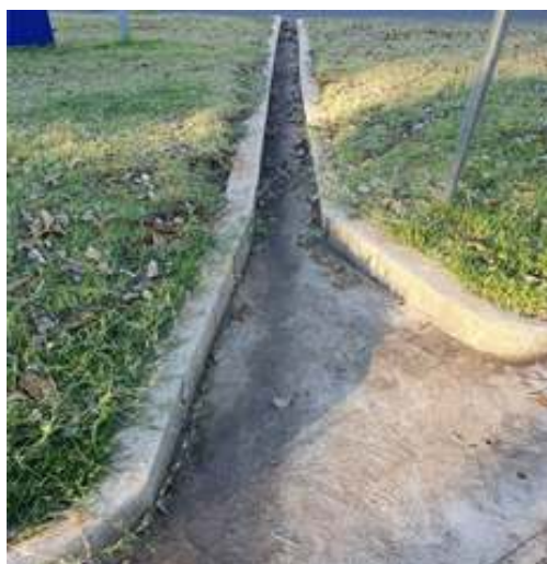
Figura 7 - Calha Implementada após alagamento
