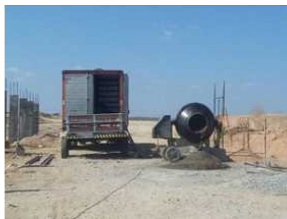
Figura 19 - Transporte da betoneira.
