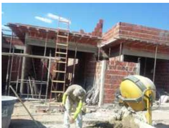
Figura 13 - Vista frontal da obra.
