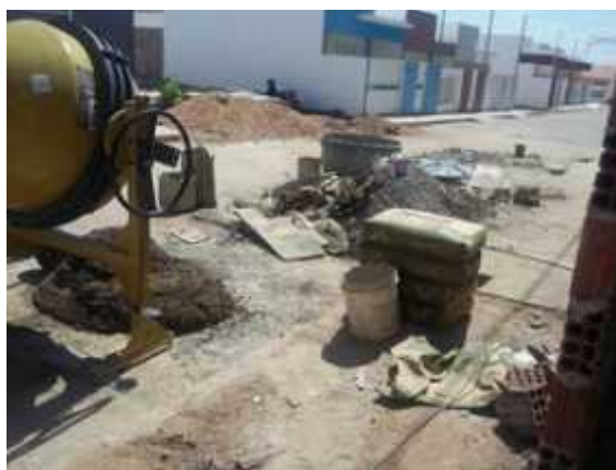
Figura 6 - Materiais dispostos na área externa e ocupando parcela da rua.
