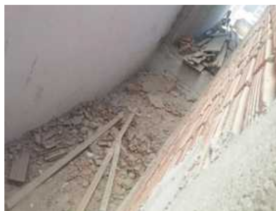
Figura 3 - Resíduos na área lateral da obra.
