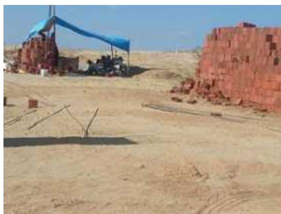
Figura 20 - Armazenamento e disposição dos materiais (no início).
