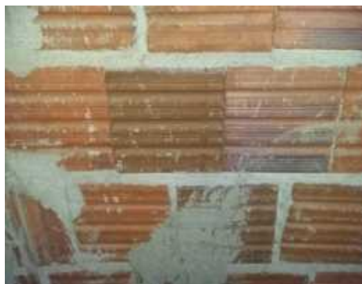
Figura 11 - Desperdício de material e irregularidade de seu uso.
