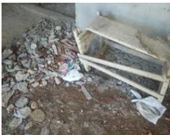
Figura 2 - Resíduos na área frontal da obra.
