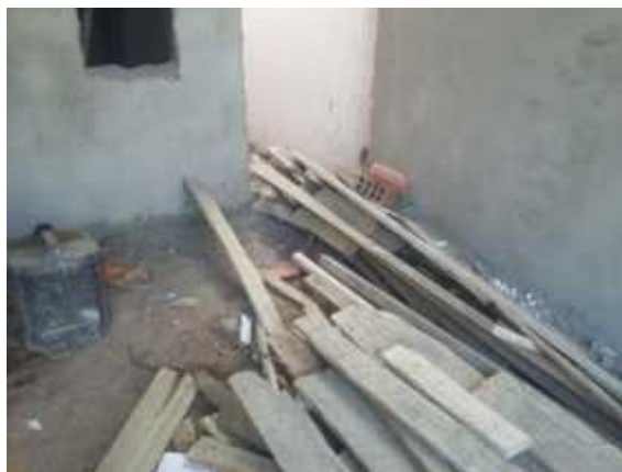
Figura 5 - Materiais dispostos de forma desorganizada na área interna.
