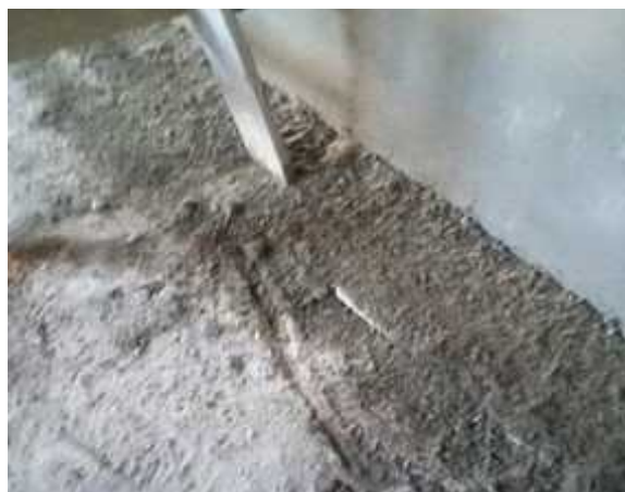
Figura 12 - Tábua aparando o material que cai.
